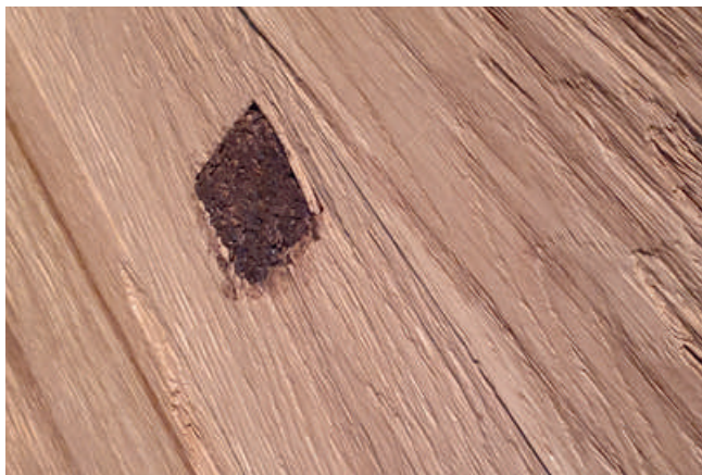
Bei der Balkeneiche werden Löcher und Risse von Hand und ausschließlich mit Echtholz geflickt.
